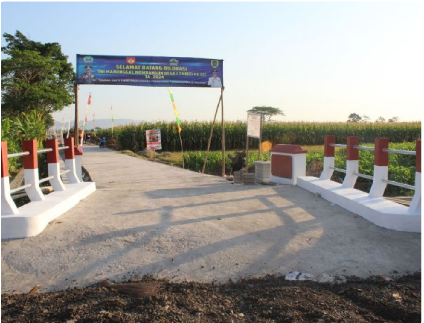
Dandim Klaten Berharap Warga Merawat Jembatan TMMD
