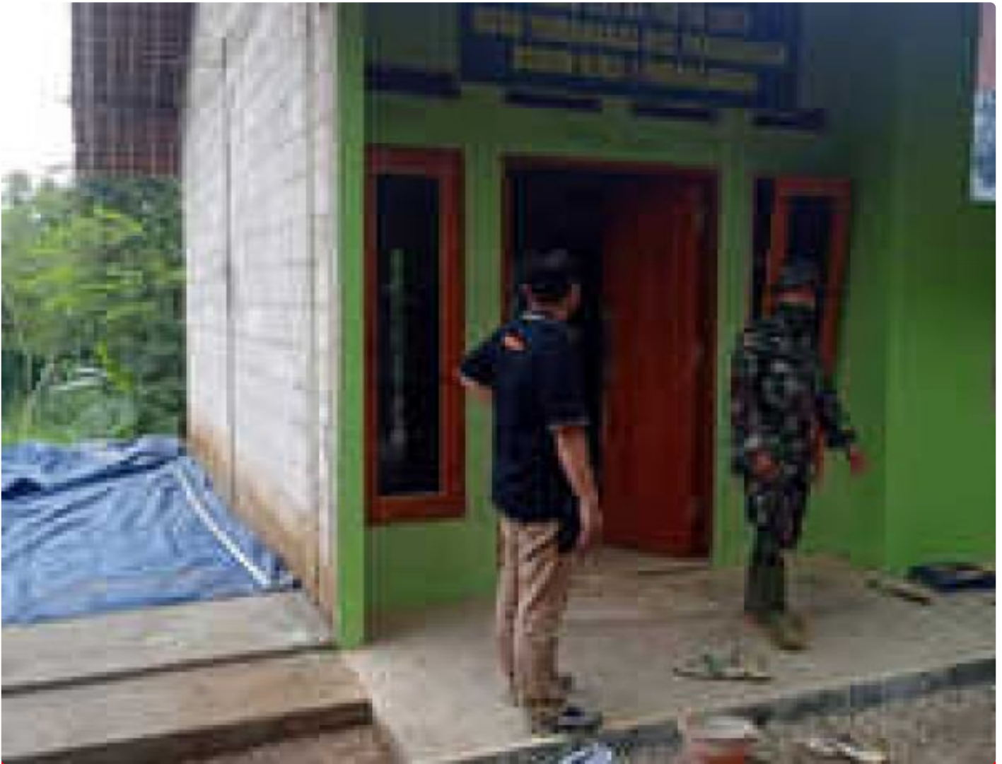
Dansatgas TMMD Cek hasil pembangunan RTLH
