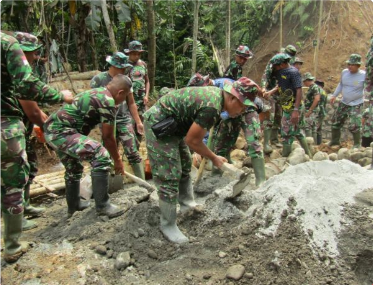
Satgas TMMD membuat adukan material secara manual
