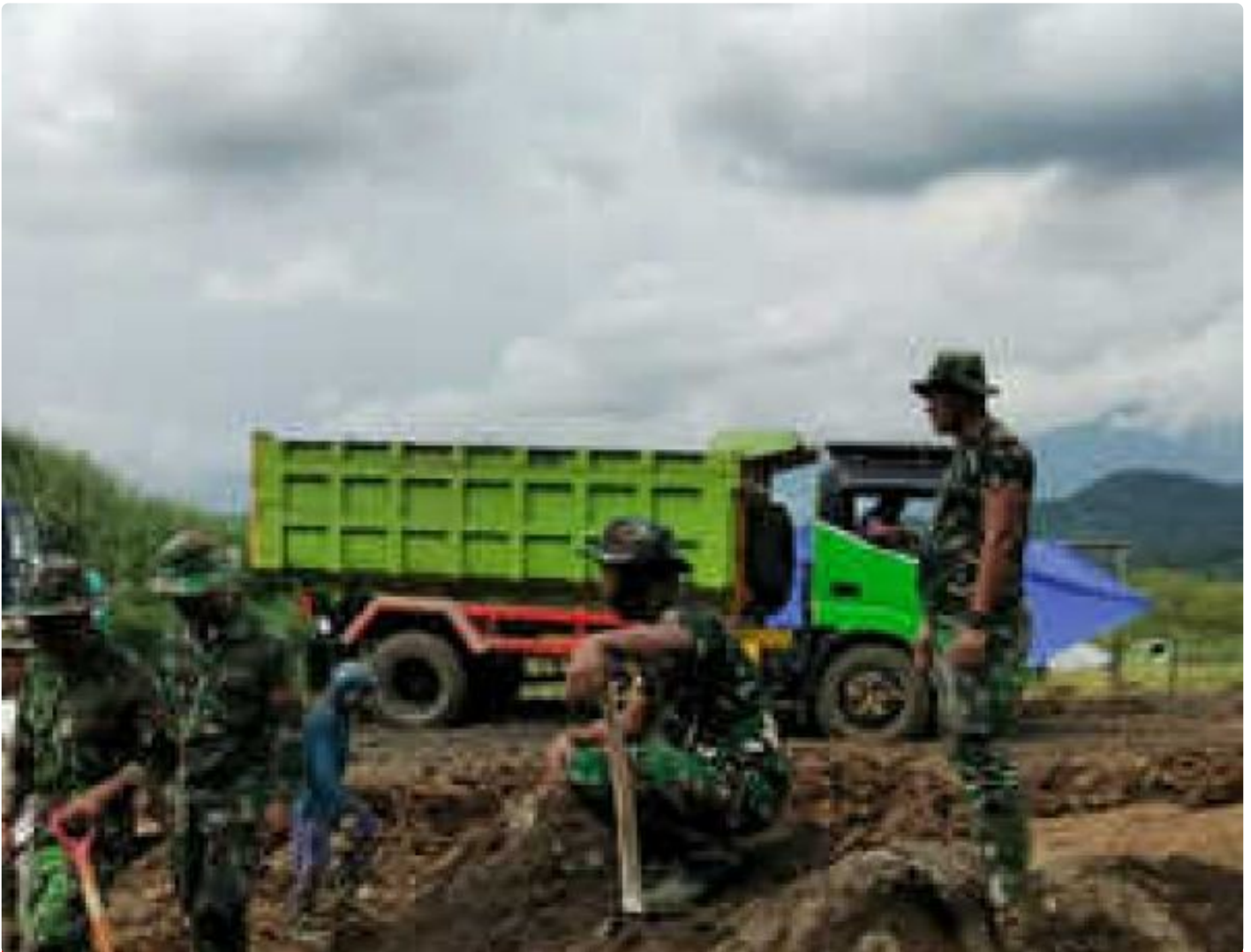
Material terus di bawa ke titik sasaran pembangunan jalan
