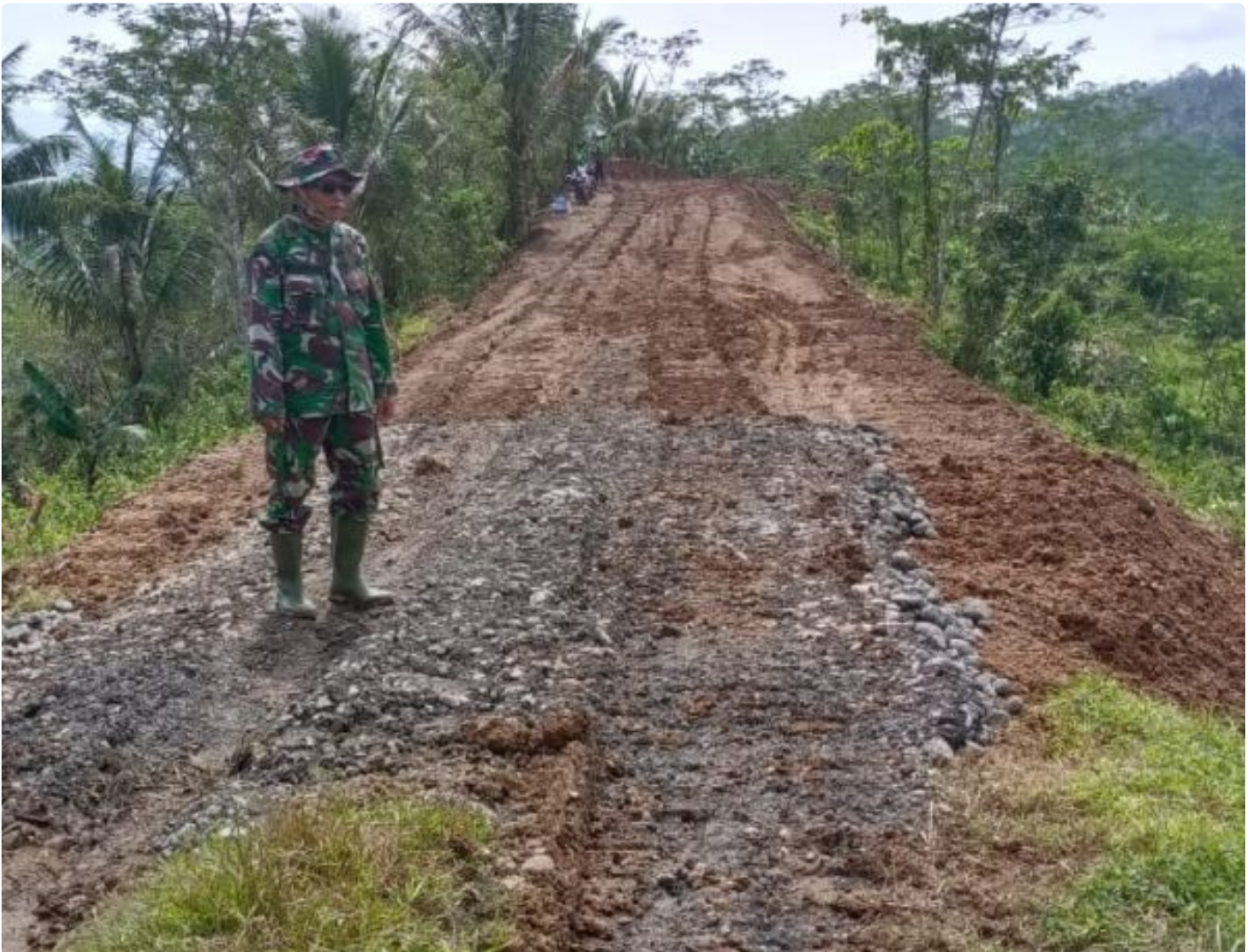
Anggota Satgas lakukan penyebaran batu dan pasir untuk pemadatan jalan
