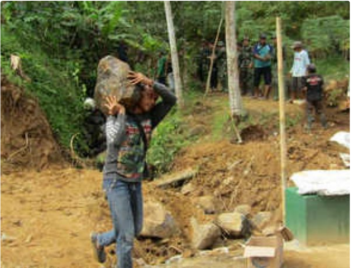
Material batu banyak untuk pemadatan jalan
