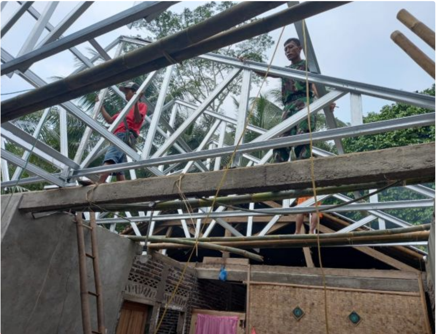
Baja ringan atap RTLH mulai dipasang
