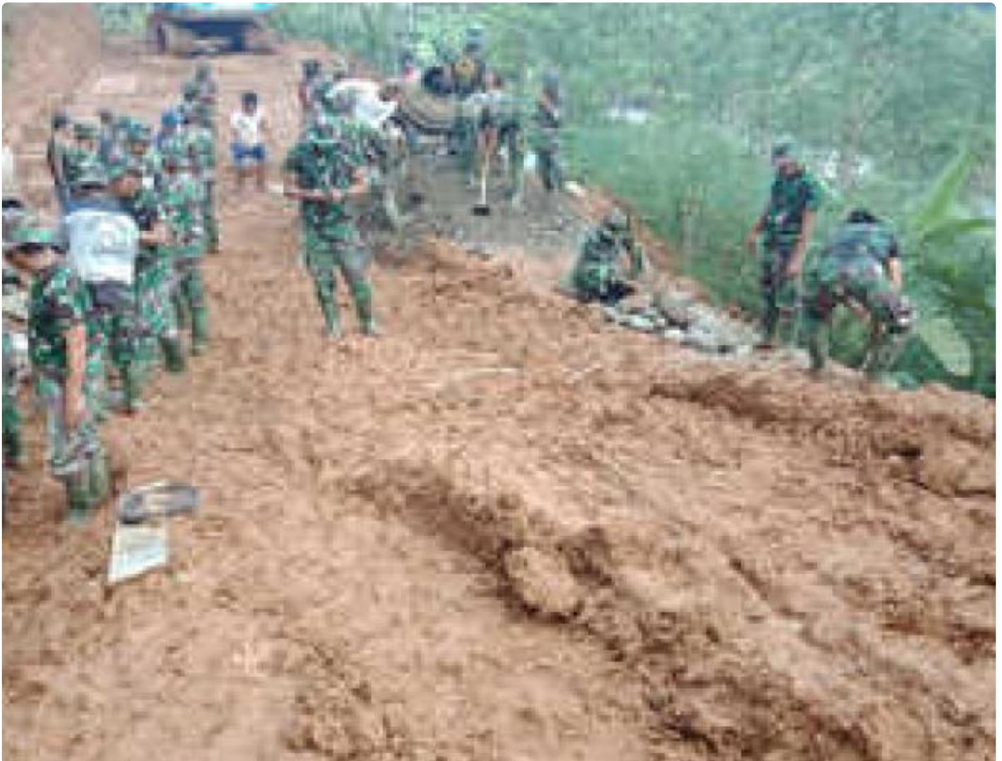
Satgas kebut pembangunan gorong-gorong
