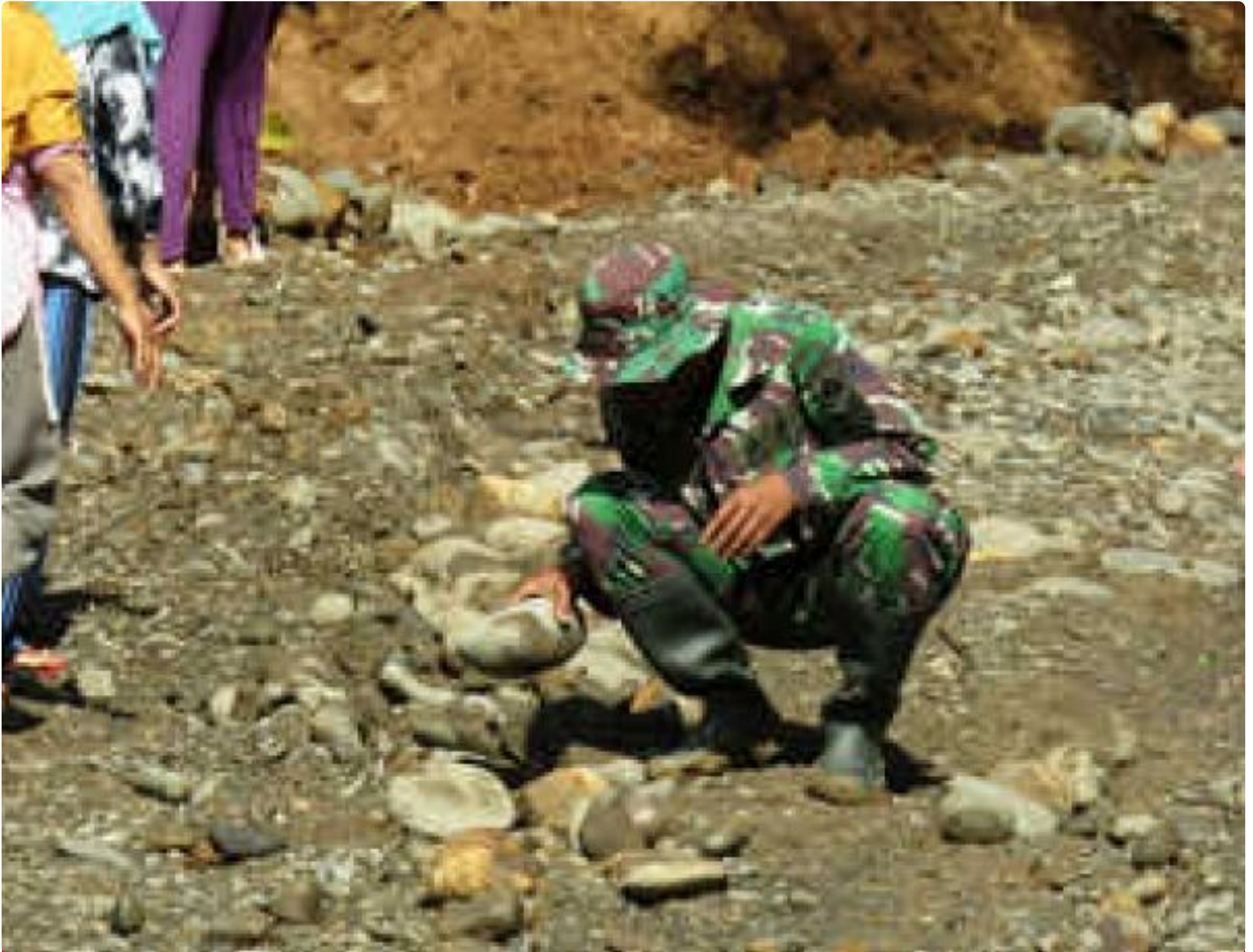
Satgas tata batu untuk pemadatan jalan baru
