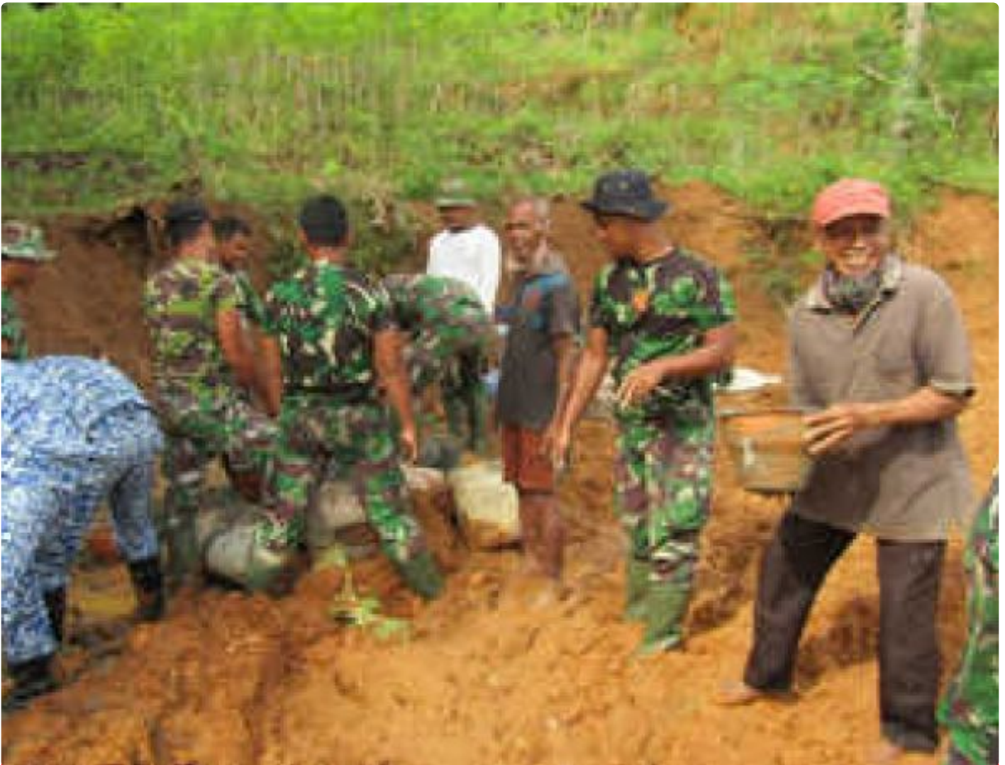
Warga bantu TMMD pembangunan jalan baru
