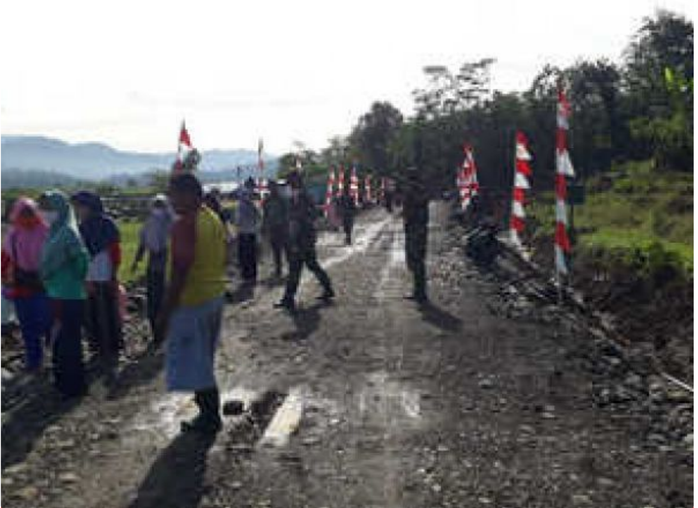
Warga dan Satgas selesaikan jalan makadam
